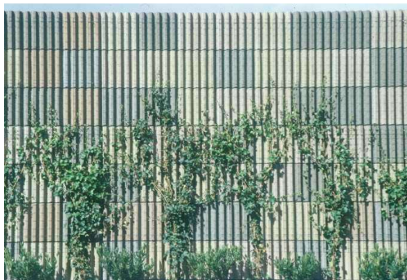
Esempio parapetti fonoassorbenti in pannellature in legno e in cls di argilla espansa
