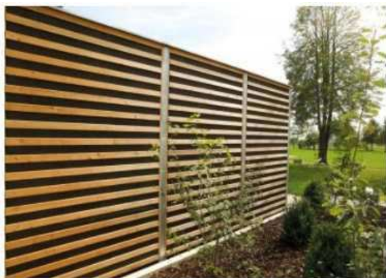
Esempio parapetti fonoassorbenti in pannellature in legno e in cls di argilla espansa
